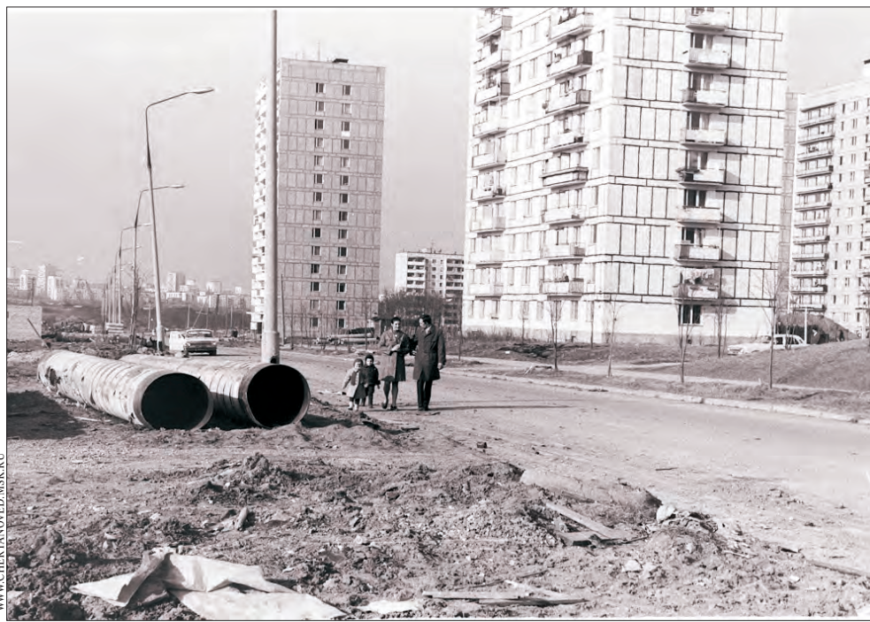
Строительство в районе д. 23 по Сумскому проезду, 1975 г.
